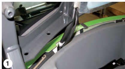
Вкарване на кабелите
