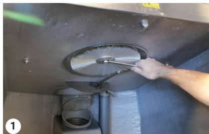
1 Demontáž rotačního filtru
