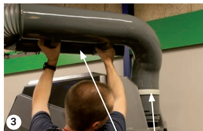
3 Montáž:Skladovací přihrádka Podpůrný prstenc
