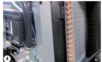
4 Kühler mit Luftdruck reinigen
