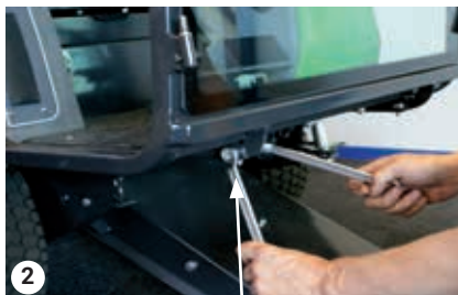
Bolzen unter der Bodenplatte
